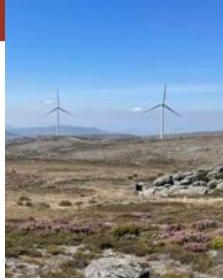
TÂMEGA WF IBERDROLA; PORTUGAL; 274MW; 38xVI72-7.2MW
