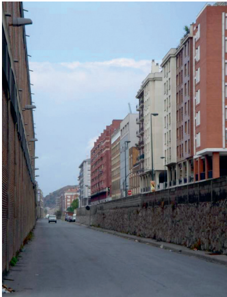
El Puerto suponía una barrera para la ciudad que se acababa junto a su muro (© APB).
