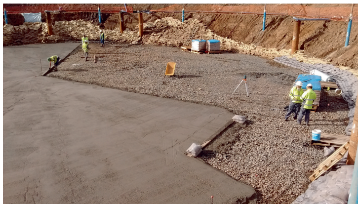
Labores de adecuación del fondo del dique seco interrumpido por la inundación proveniente del nivel más alto de la marea.
