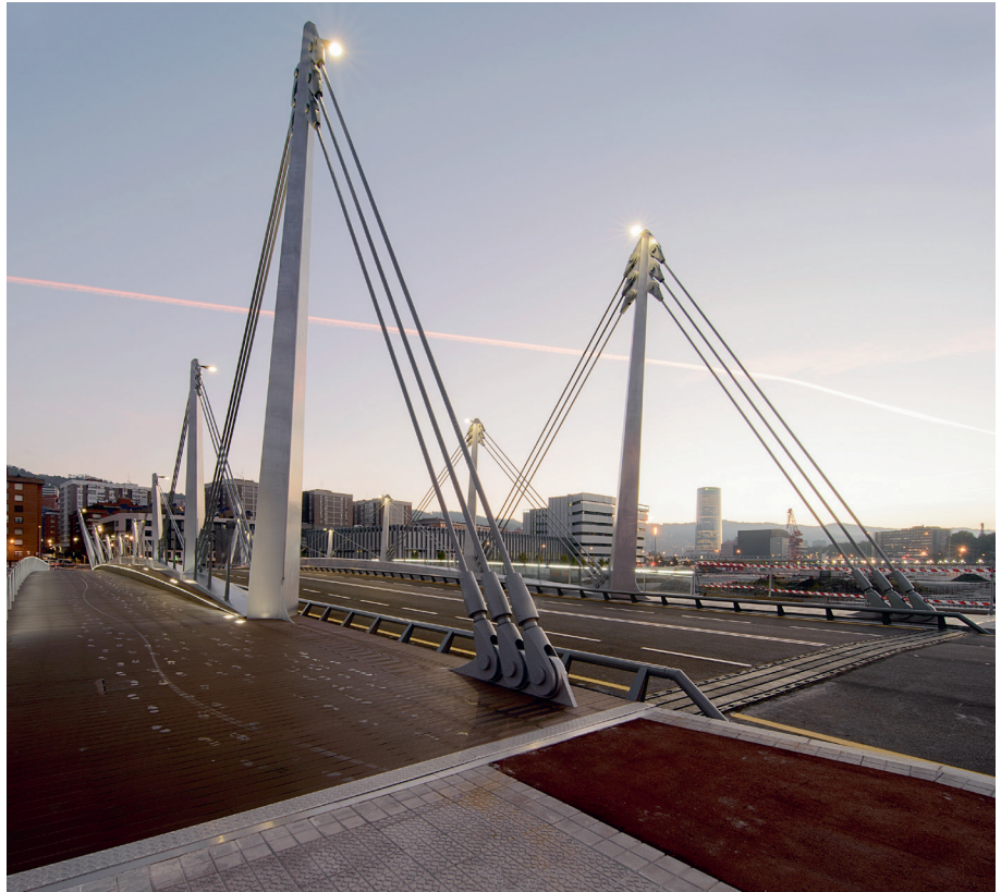
Puente Frank O. Gehry, diseñado por Guillermo Gapellán y Héctor Beade de la empresa Arenas Ingenieros Asociados (© CGdeZ).
