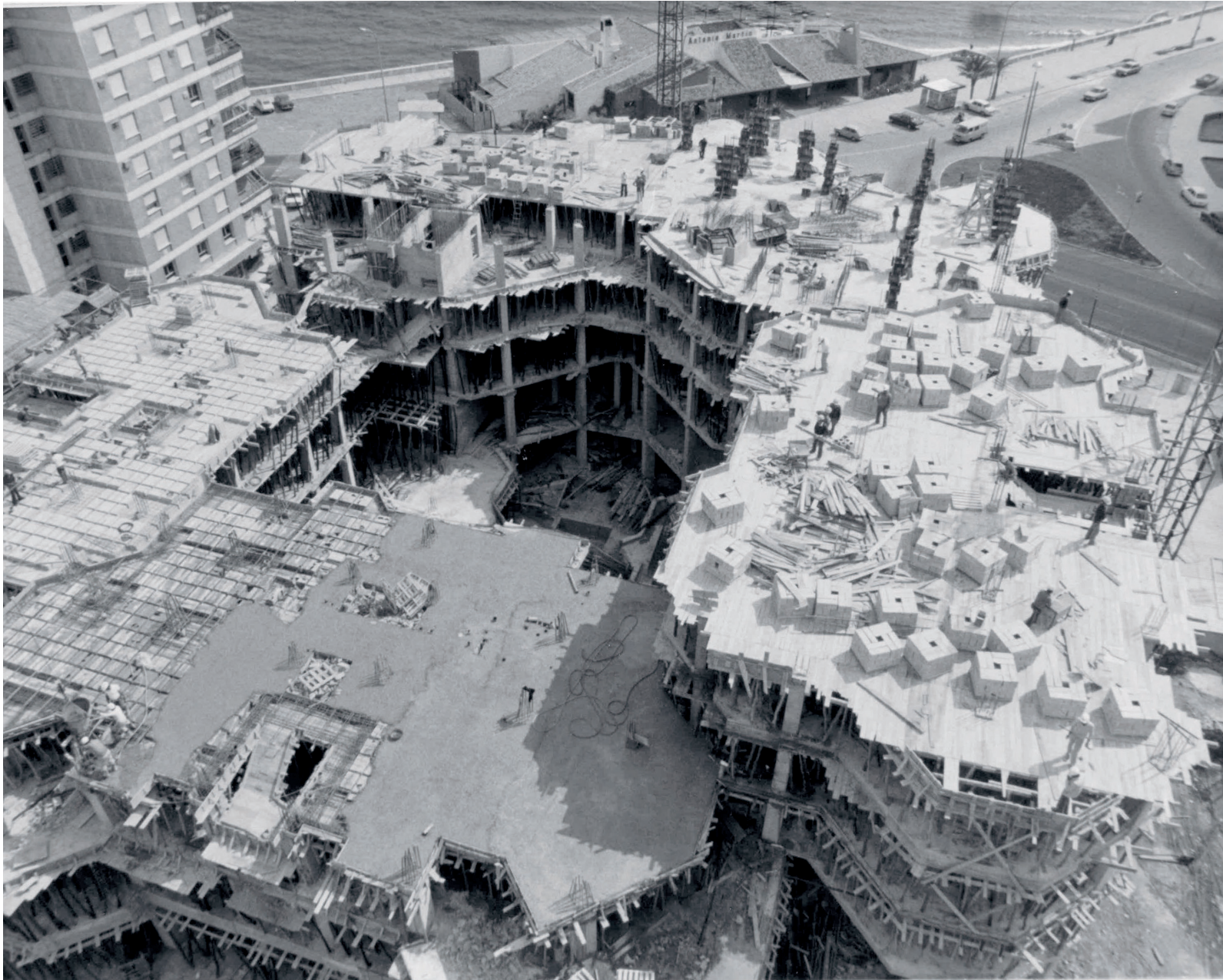
Edificio Horizonte de Málaga en construcción.
