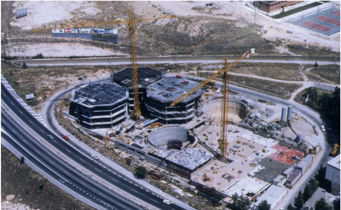
Edificio de oficinas Mirasierra, Madrid.
