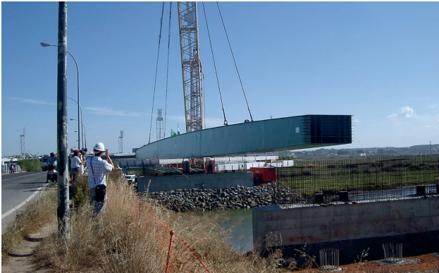
Puente de Isla Canela-Ayamonte (Huelva).
