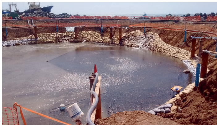
Labores de adecuación del fondo del dique seco interrumpido por la inundación proveniente del nivel más alto de la marea.
