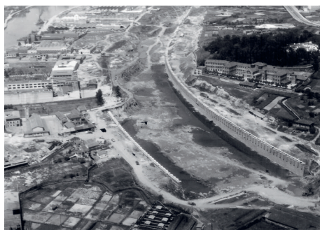
Vista aérea de las obras de la apertura del Canal de Deusto en 1959 (© APB).
