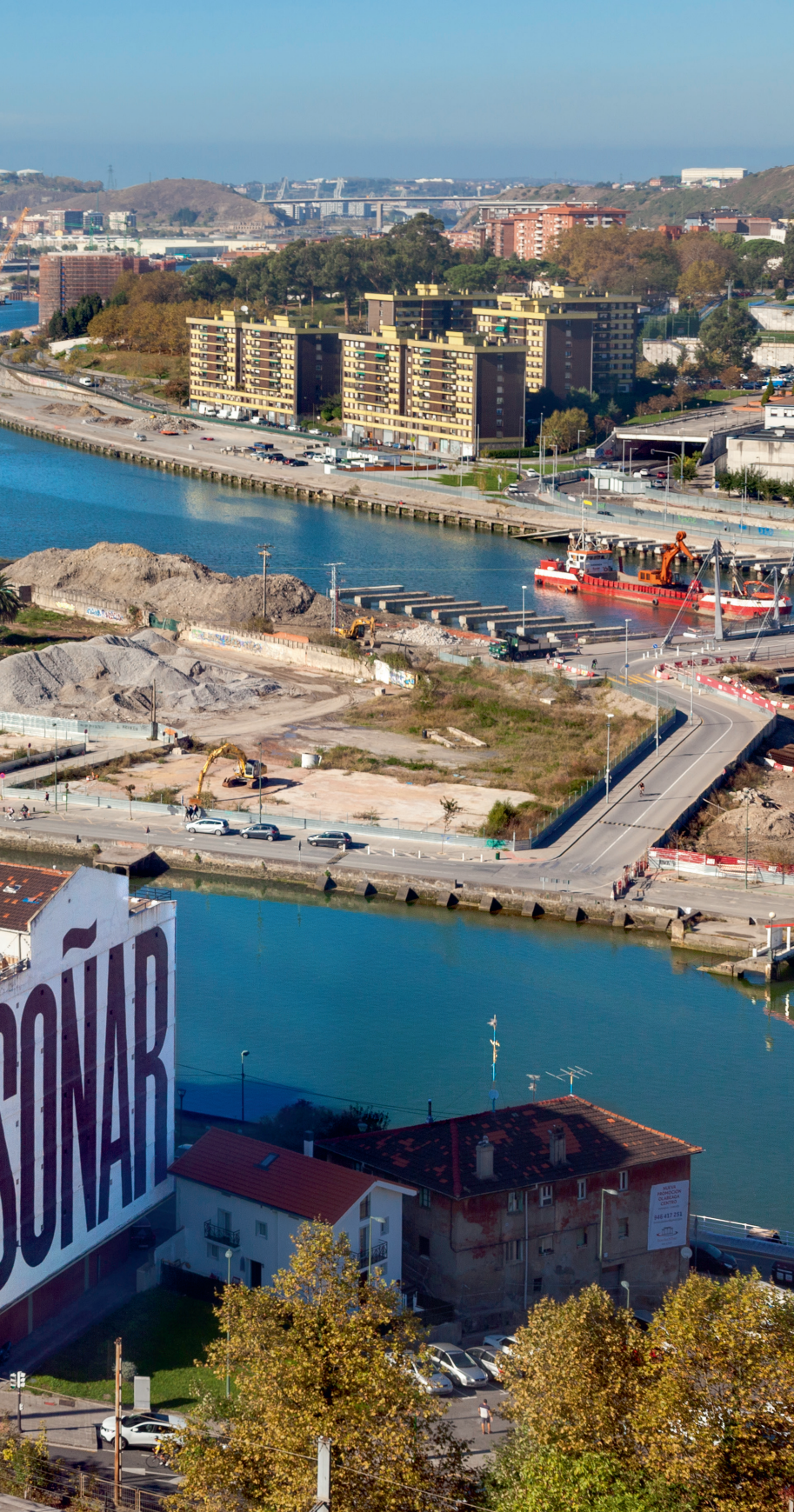
La península de Zorrotzaurre, antes de la apertura del Canal (© Aitor Ortiz).
