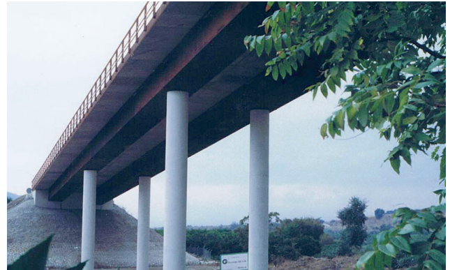
Puente de Alora (Málaga).
