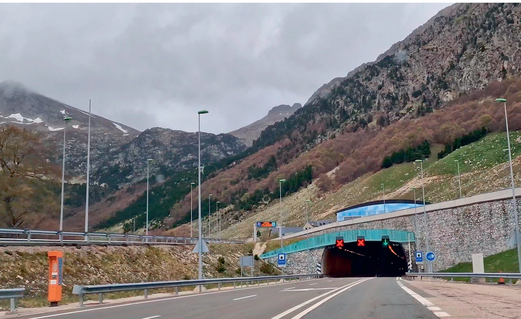
Túnel de Vielha, el actual desde 2007.
