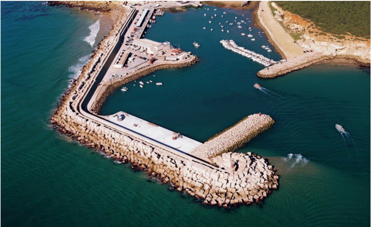
Muelle y contradique de Conil (Cádiz).
