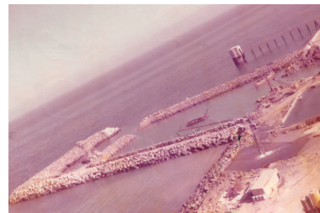
Toma Marina de Jinámar, en construcción.
