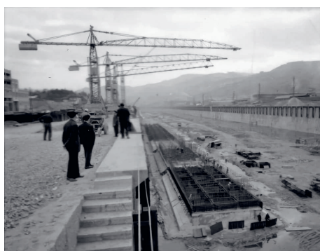
Estado de las obras de la apertura del Canal de Deusto en 1966 (© APB).
