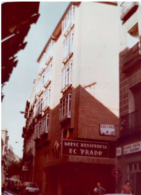
Hotel de la calle Prado, Madrid.
