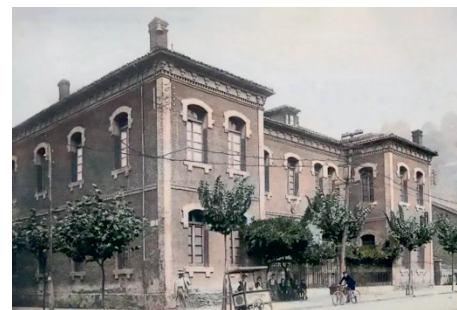
La escuela de Capataces de Minas, Hornos y Máquinas se inauguró el 31 de julio de 1884 (© Blog de Acebedo).
