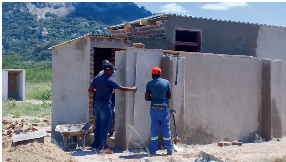
Abiatha Chihava, ingeniero de salud pública en Oxfam Intermón, supervisa las letrinas que se están construyendo para niñas en la escuela Ngomeyebani, en Zimbabue (© Collin Nduna/Oxfam).
