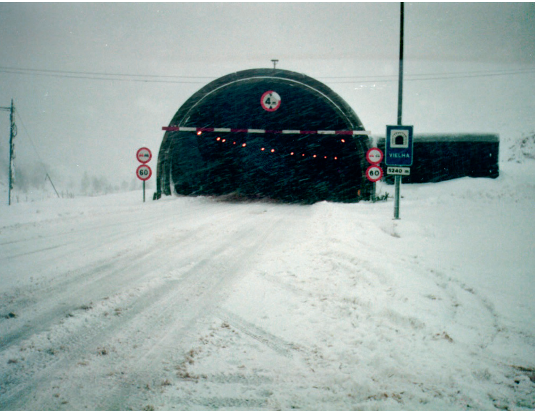
La vialidad invernal en las carreteras. Túnel de Vielha, 2001.
