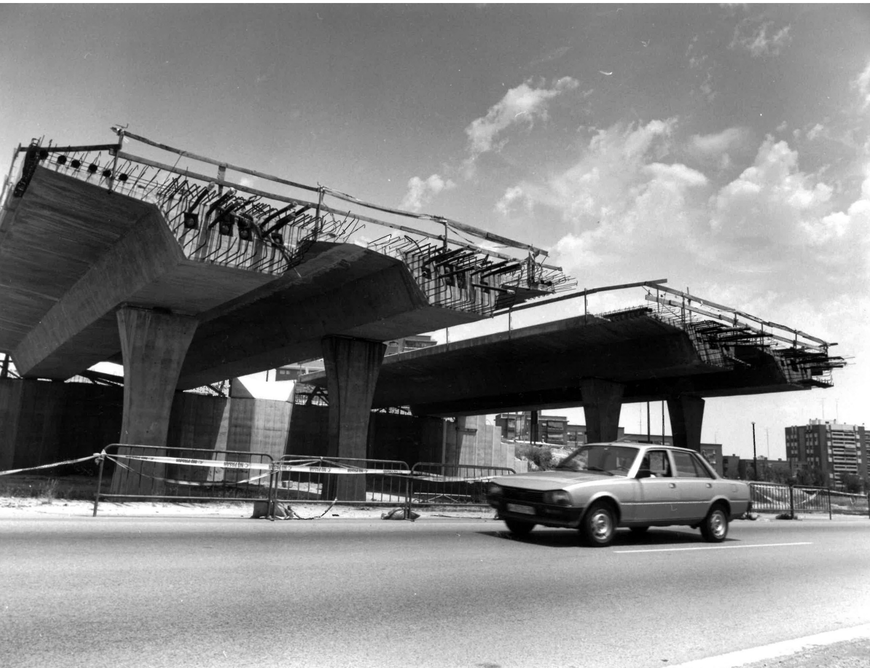
Ejecución del puente sobre la autovía A3 que conecta Moratalaz y Vallecas (Madrid).
