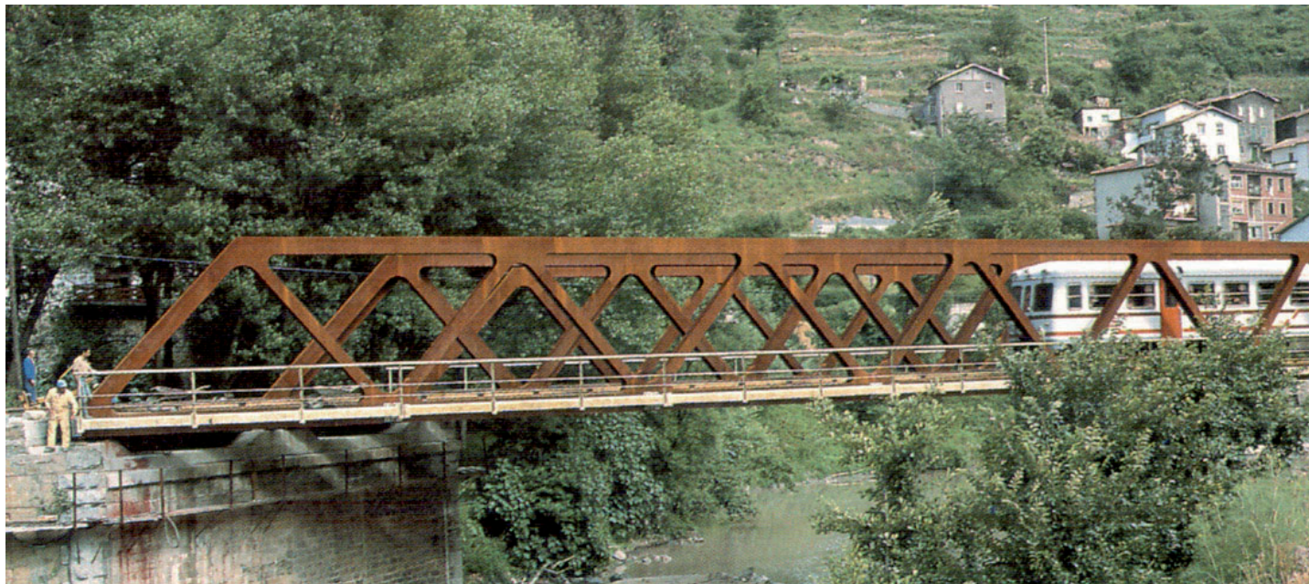
Puente de ferrocarril de Castrejana (Vizcaya).
