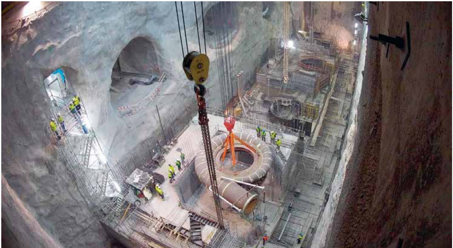
Central de Gouvães. Caverna y montaje cámara espiral © Iberdrola.
