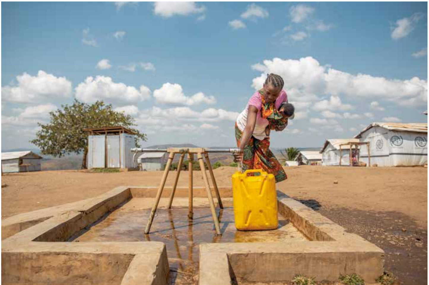
Hernestine, sacando agua del grifo suministrado por Oxfam Intermón en la instalación fotovoltaica del campo de desplazados de Mweka, en la República Democrática del Congo. © Arlette Bashizi/Oxfam.
