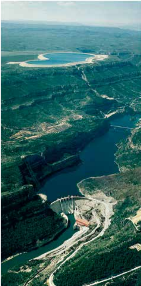
Complejo hidroeléctrico Cortes-La Muela. © Iberdrola.
