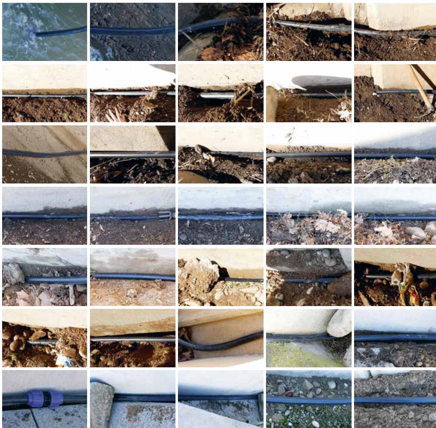
Instalación permanente de una manguera de 200 metros escondida para desviar 40 l/h de un canal hacia un río.
