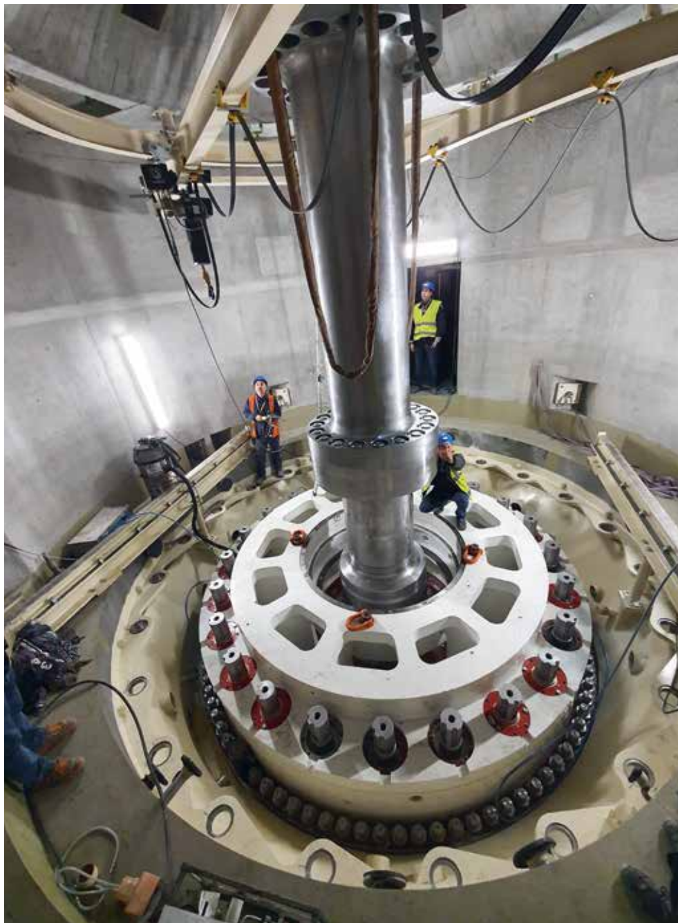
Central de Gouvães. Montaje del distribuidor. © Iberdrola.
