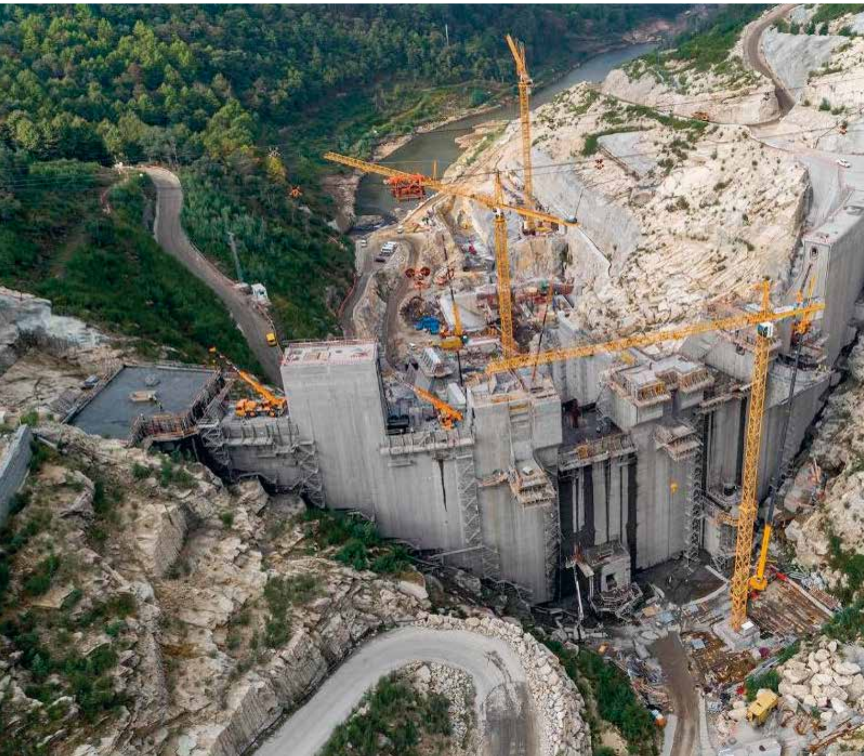
Presa de Alto Tâmega. © Iberdrola.
