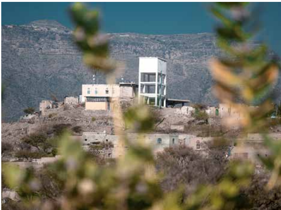
Tanque de agua construido por Oxfam Intermón en Al-Dhale (Yemen). La ONG rehabilita infraestructuras de agua y líneas de suministro dañadas por el conflicto junto a la Corporación local de agua y saneamiento, además de instalar plantas desalinizadoras de agua. ©VFX Aden/Oxfam.
